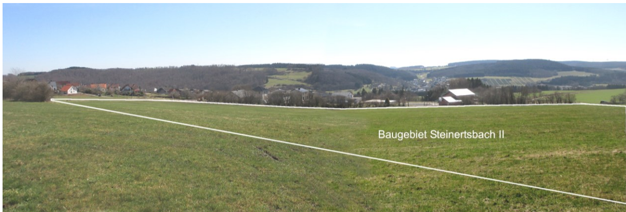
Blick von Norden auf das Baugebiet.
